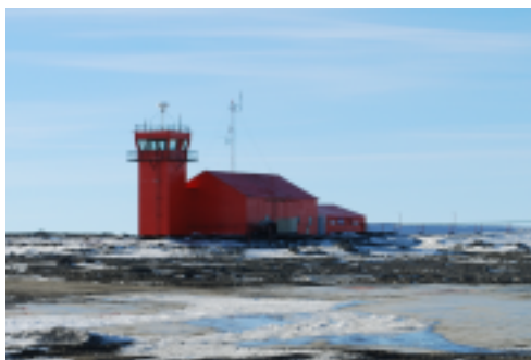
Torre de control
